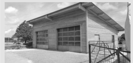
OGV-Lagerschuppen bei der Einweihung 28.08.2022 Foto: Alfred Schaz
